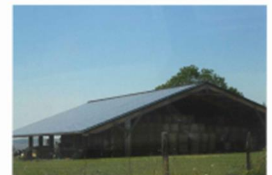
Hangar récent à toiture solaire, secteur de Montredon-Labessonnié
