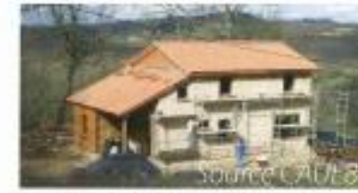
Auto-construction en paille, isolation liège
