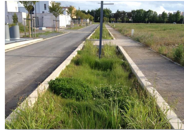
Noue urbaine à plantes semi-aquatiques
