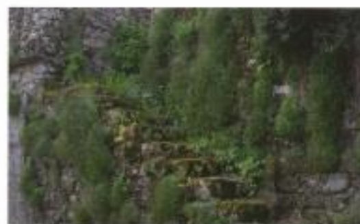
Murs de soutènement et escalier, hameau de Villelongue
